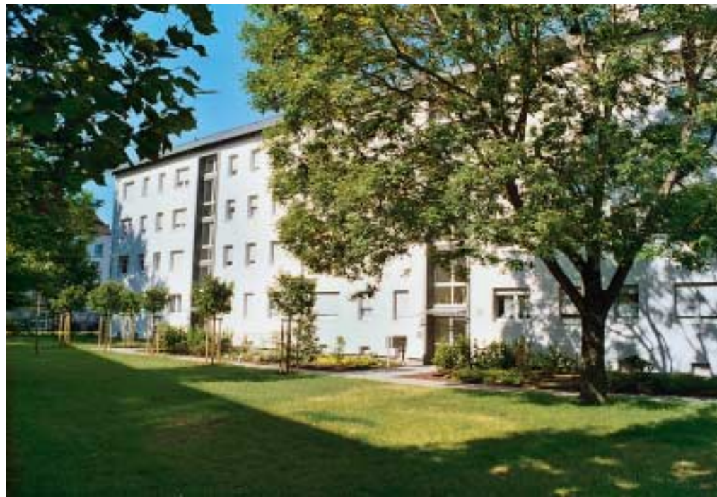
Erneuerung von Dach, Fassade und Heizung, verbunden mit neuer Außenanlage: Bausteine eines gelungenen Face-Liftings in der Hans-Sachs-Straße 26 – 28
