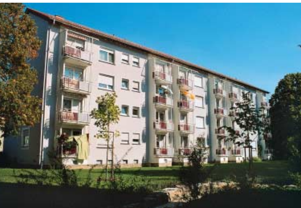
Umfassende Sanierung an Dach, Fassade und Balkonen sichert die nachhaltige Vermietung: Sturzkopf 9 – 11
