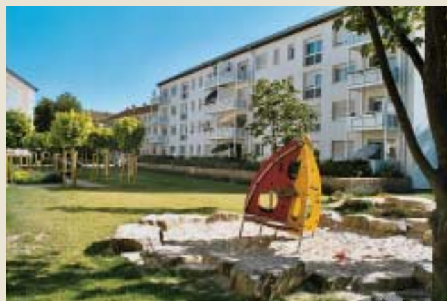
Umfassende Wohnhaussanierung mit Vollwärmeschutz und Neueindeckung. In die Fassadengestaltung sind vorgeständerte Balkone und Terrassen einbezogen worden: Hans-Sachs-Straße 22, 24 und 26
