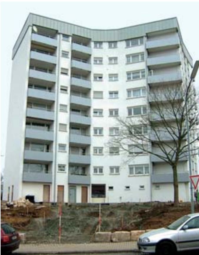
Uhlandstraße 1 Das Y-Hochhaus mit Wohl- fühlqualitäten: Grundlegende Sanierung des Gebäudes.
