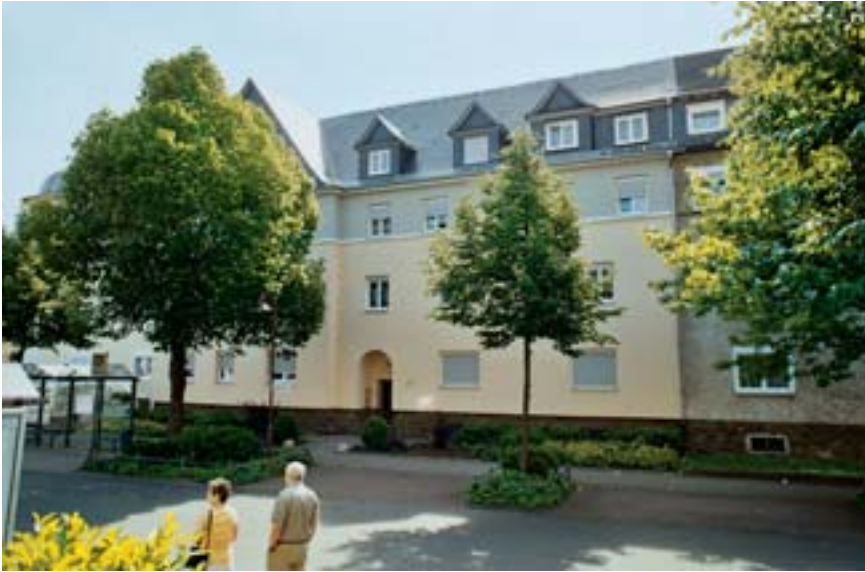
Niedergirmeser Weg 70 Stadtbildverträglich saniert.
